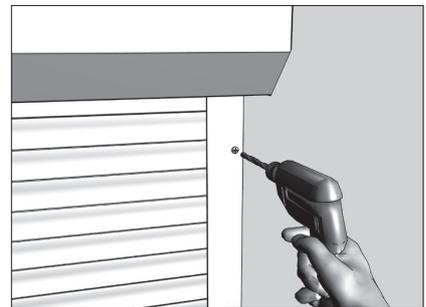
После окончания монтажа в целях повышения защитных свойств роллеты шляпки винтов и шурупов, крепящих направляющие и короб должны рассверливаться.
